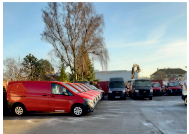
Diese Mercedes-Transporter stehen bereits auf dem ehemaligen Flöttmann-Betriebsgelände. Im Hintergrund ist der Arm des Abrissbaggers zu sehen.
